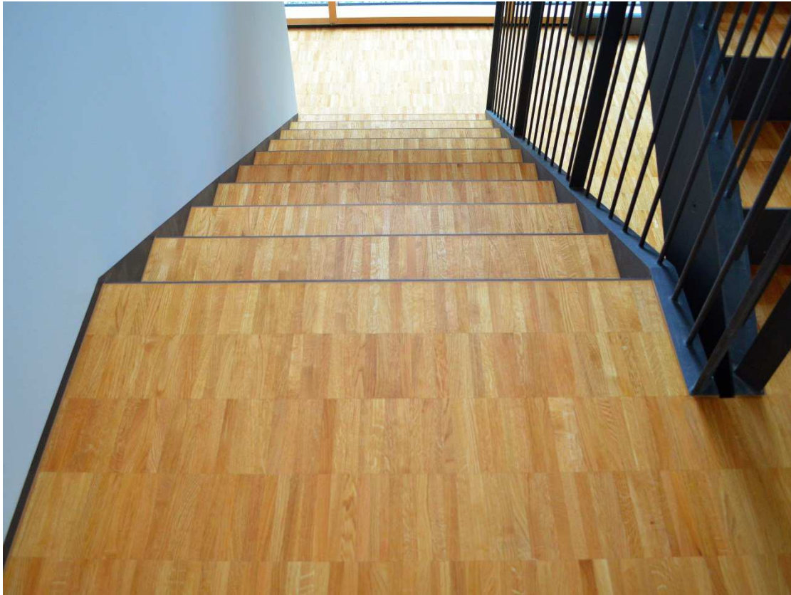
Treppen mit Parkett belegt sowie die Handläufe aus Eiche...
