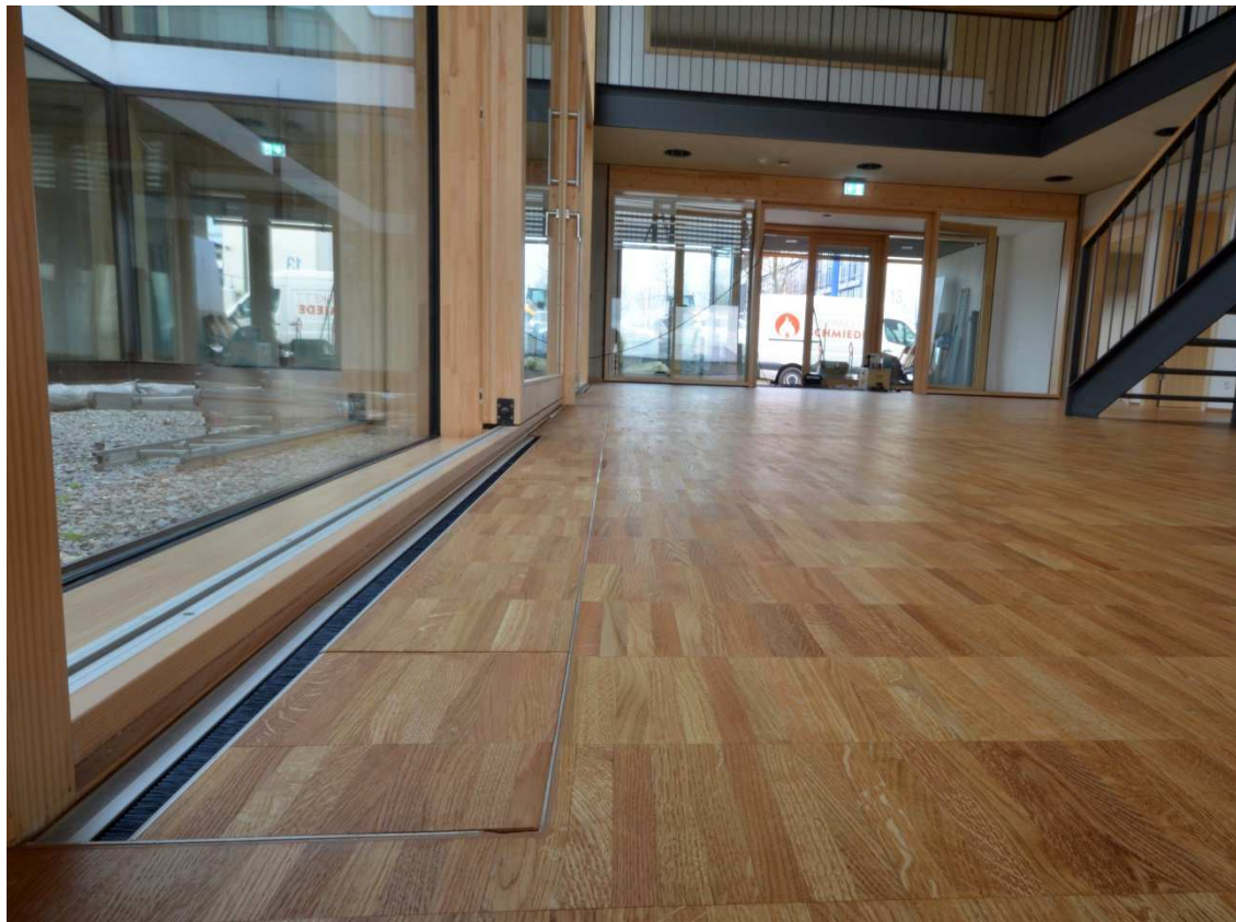
Selbst im Streichlicht kaum sichtbar: die fensterseitigen Bodentanks.
