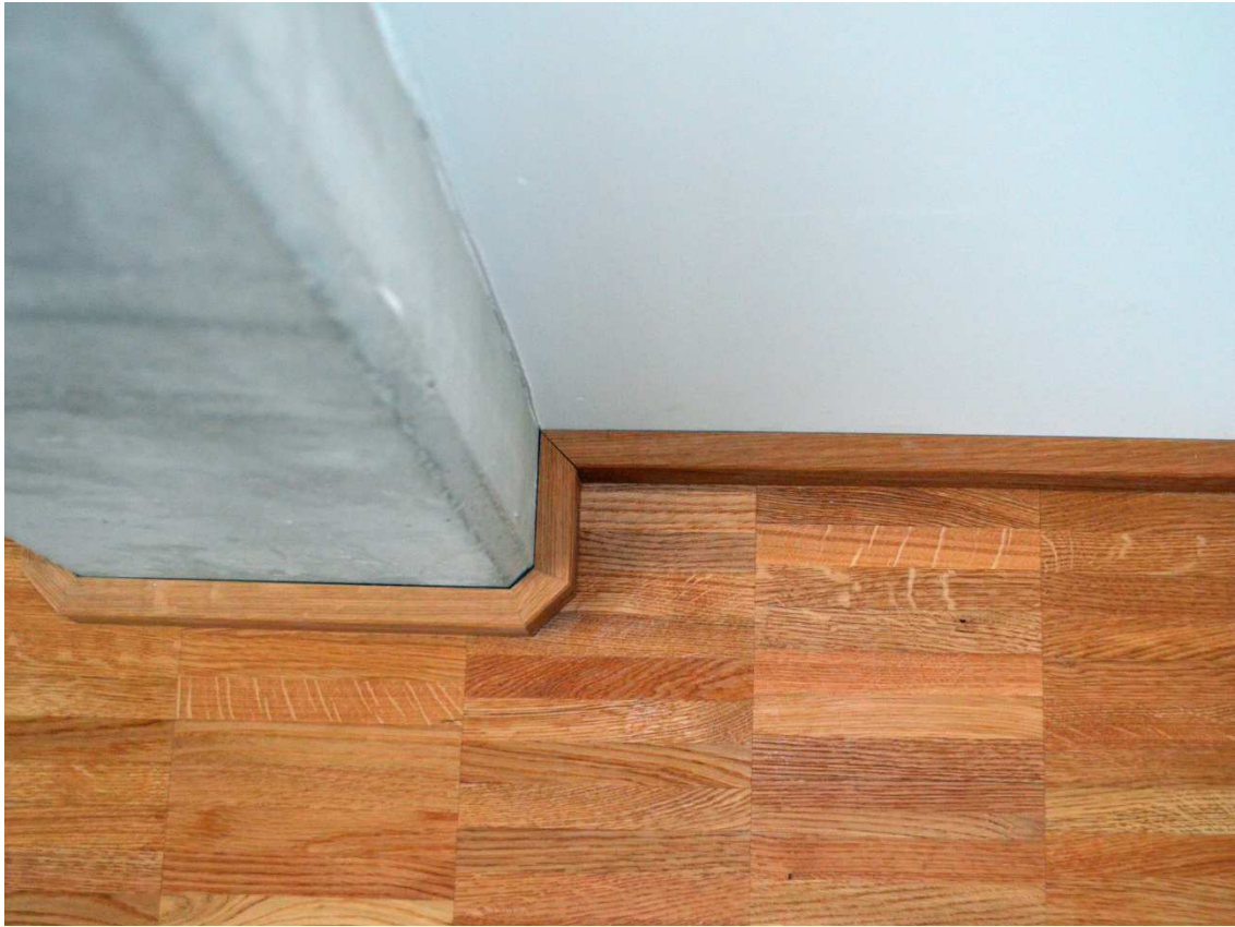
Perfektion im Detail 1: Die Einfassung der gefasteten Betonsäulen mit Sockeln aus Eiche.
