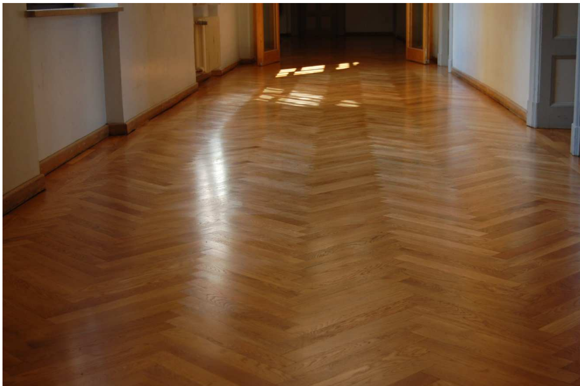
... und heute nach sechs Jahren Sanierung mit Olio-Therm®.
